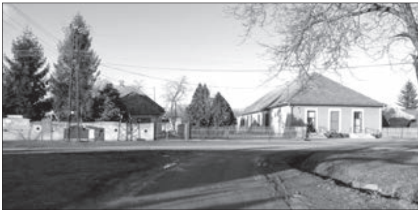
Az átépített iskolaépület napjainkban
